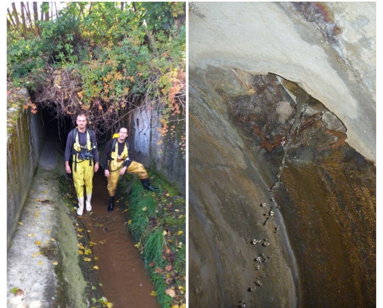
▲ Zlín - kontrola podzemních prostorů
