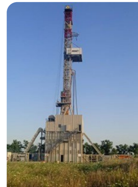
▲ San Giovanni1 - Demontáž vrtné soupravy Bentec 450 AC
