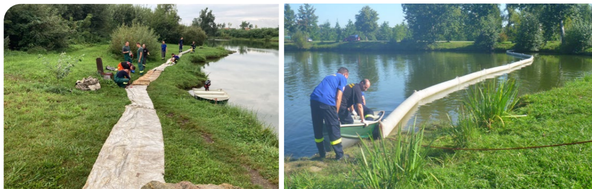
▲ Montáž norných stěn
