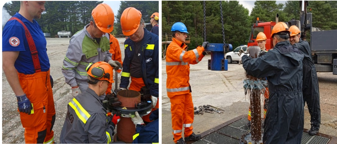
▲ Uřezání pažnice pomocí rouřežu
