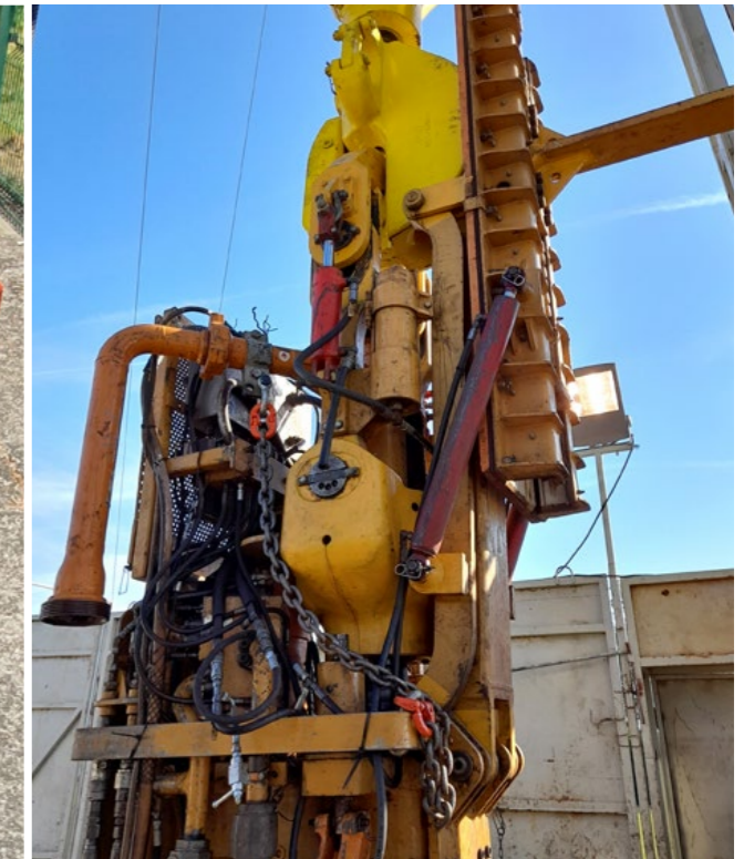
▼ Břeclav - 42 Montáž TOP DRIVE.
